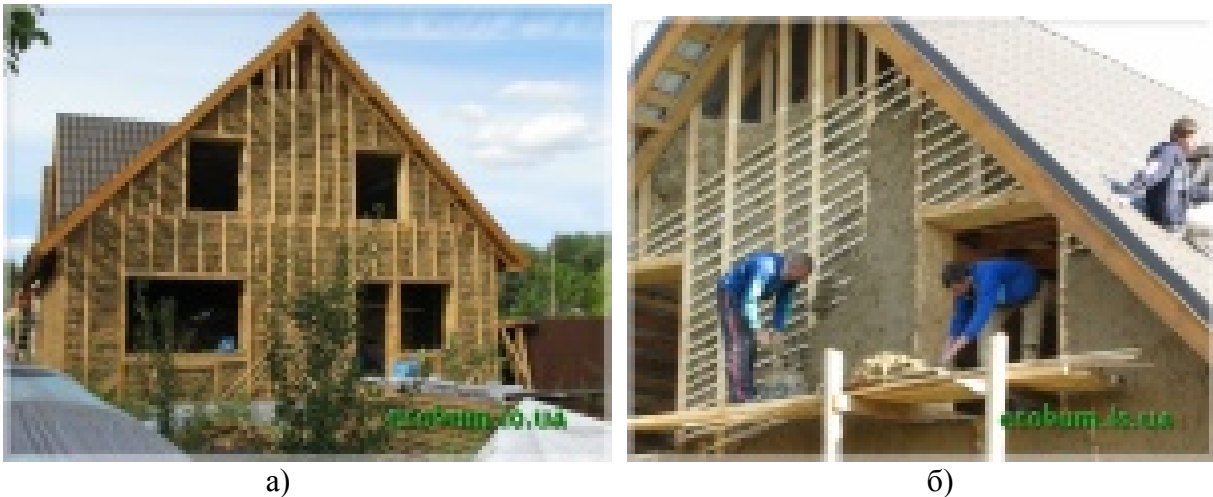
Рис. 1. Вигляд будівельного об'єкта до штукатурення (а) і під час штукатурення (б)
